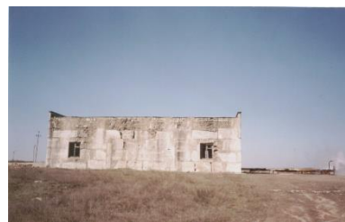
Рис. 10. Действующий тепловой пункт в селе Янтарное
