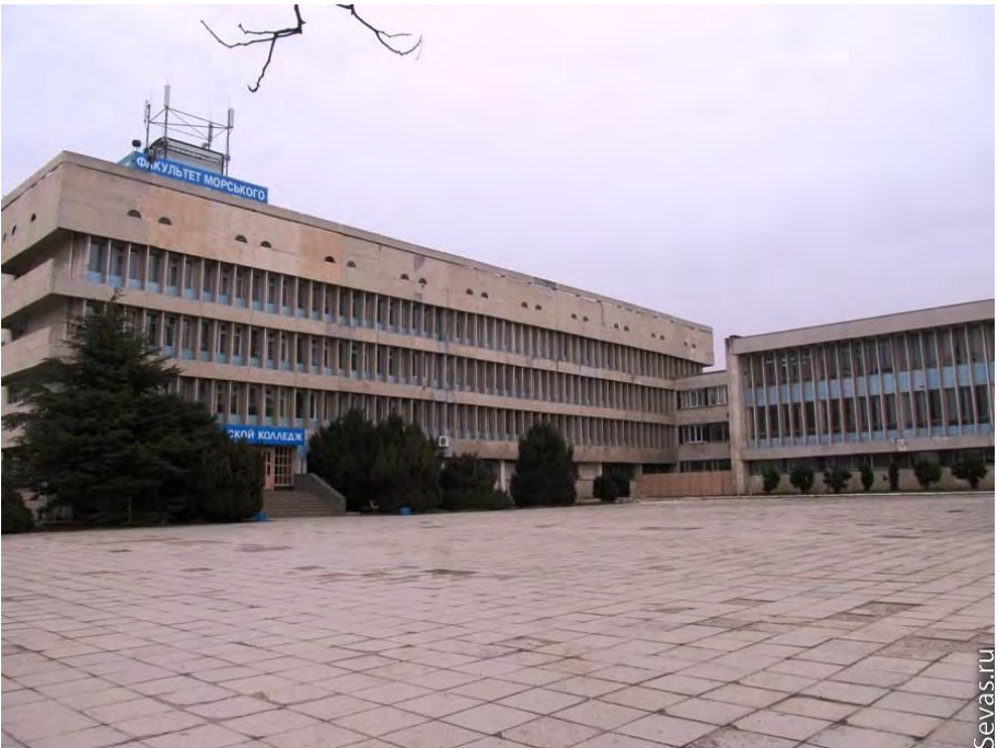
Морской колледж. Учебно-лабораторные корпуса (Существующее состояние)
