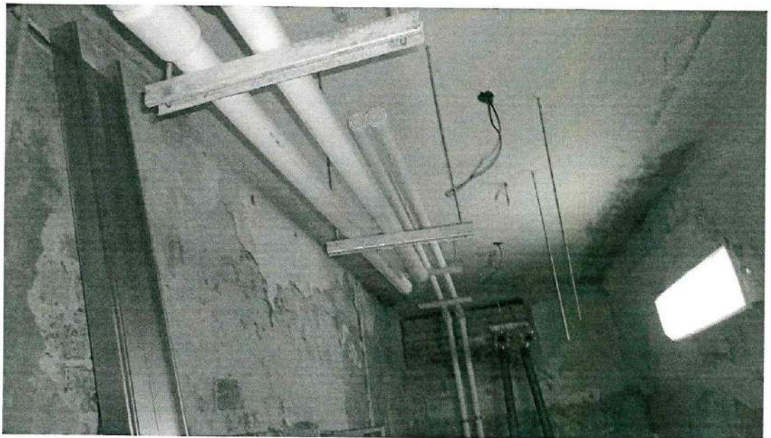
Работы по устройству отопления.
