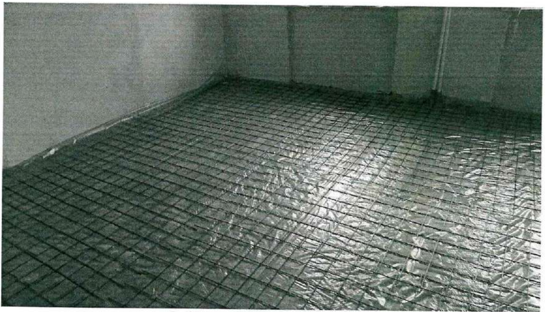
Работы по усилению перекрытий.
