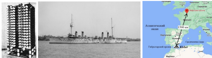
Рис. 16. Общий вид батареи из конденсаторов Мосцицкого, которая использовалась в радиотелеграфной станции на Эйфелевой башне в Париже (1908 г.). Броненосный крейсер Kleber , с которым была установлена связь с Эйфелевой башни (слева), когда он находился в Средиземном море в районе Гибралтара (1908 г.).
