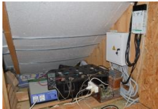
Рис. 9. Соединение аккумуляторов
