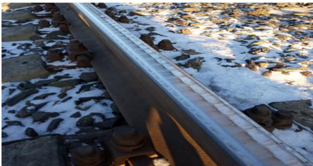
Рис. 5.4 - Фрагмент ликвидации заводской неровности композиционным шлифовальным кругом на поверхности рельса
