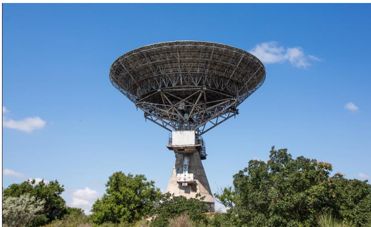
Рис. 1. Приемно-передающая антенна ТНА-400.
