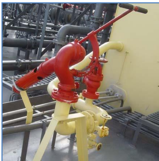
Рисунок 2.5 - Пожарный ствол
