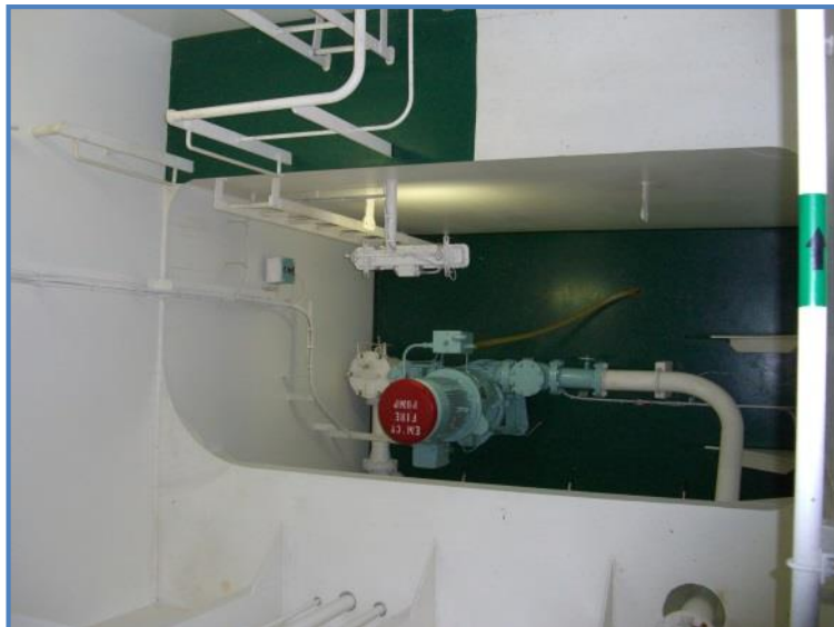
Рисунок 1.1 – Пожарный насос
